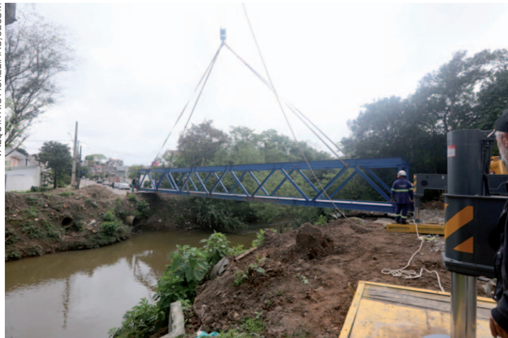
Içamento e montagem da estrutura metálica sobre a ponte do Rio Barigui, que formará a nova passarela de pedestres ligando as ruas Júlia Domakoski e Tito Calderari
