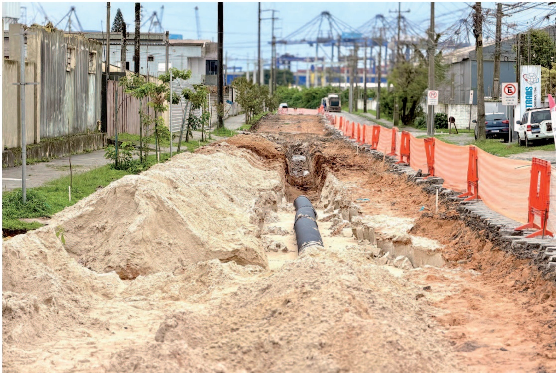
As intervenções avançam para o trecho entre a Rua Desembargador Ermelino de Leão e o encontro das avenidas Portuária e da Costeira
