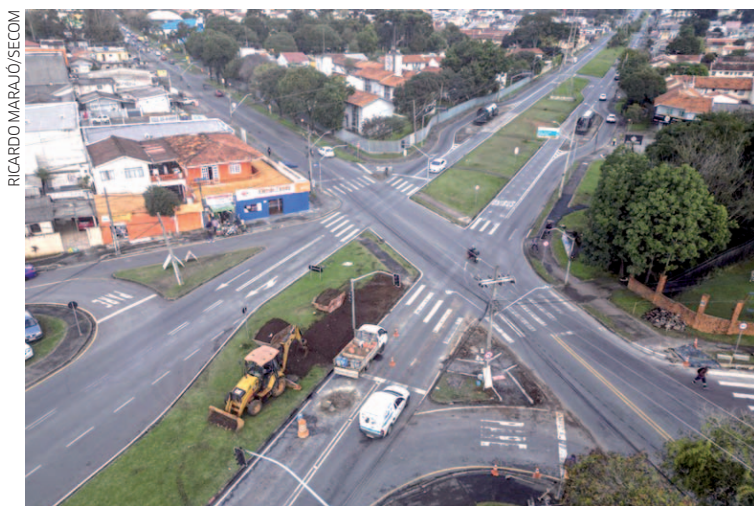
Implantação de rampas de acessibilidade no cruzamento das ruas Pastor Antônio Polito, com a Wilson Dacheux Pereira, no Alto Boqueirão
