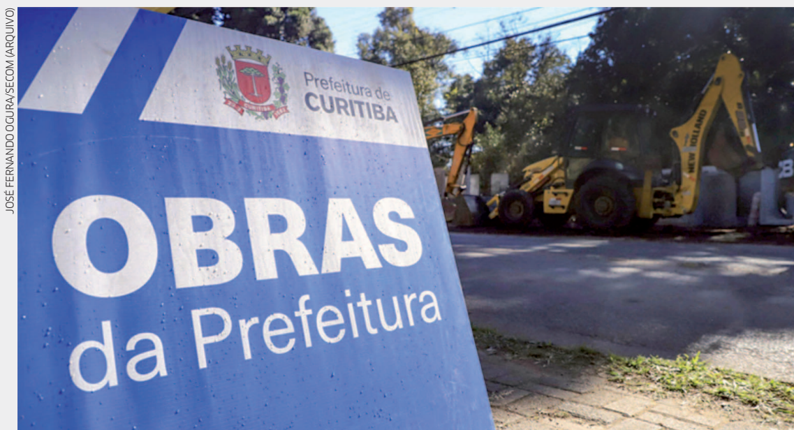
Os serviços incluem escavação da pista, recomposição das camadas de reforço do pavimento e execução de concreto
