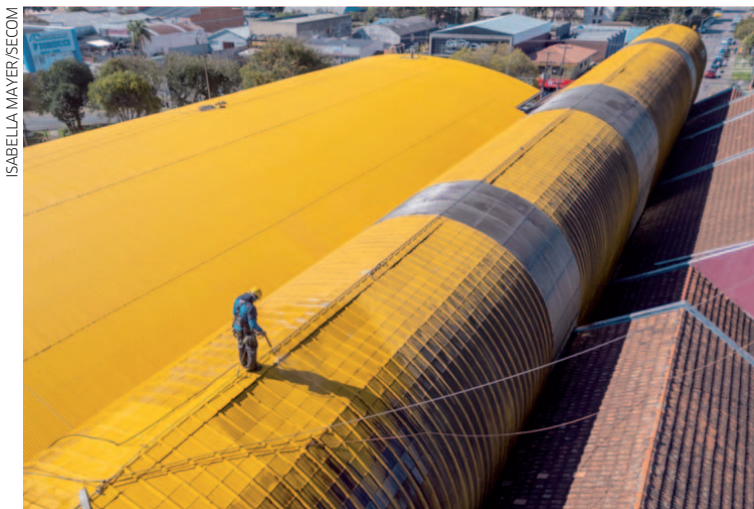
Lavagem e reparos da cobertura da Rua da Cidadania do Boqueirão
