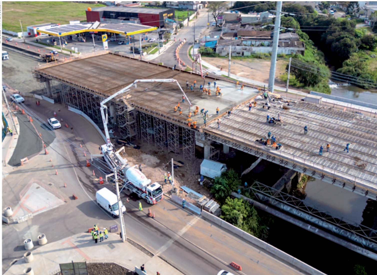
Nesta primeira etapa, dois dos cinco vãos que formam o viaduto recebem o concreto
