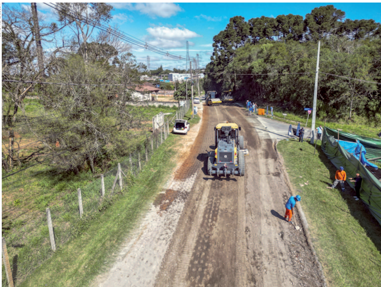
Prefeito Eduardo Pimentel vistoria as obras de reciclagem do asfalto da Estrada do Ganchinho
