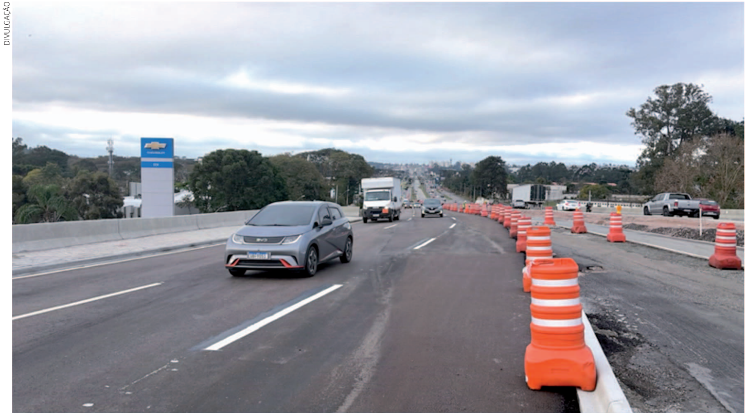
As intervenções no Complexo Tarumã entram na fase da implantação das canaletas exclusivas
