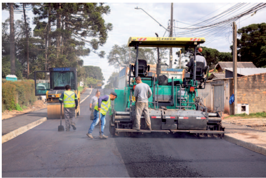
Após execução das obras de preparação, a pista e o calçamento receberam o CBUQ a partir da rua Heitor Pallu
