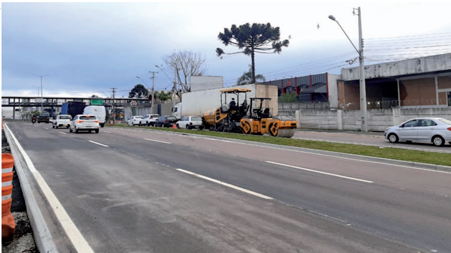
Novo avanço permite liberação do tráfego na Linha Verde nos dois sentidos
