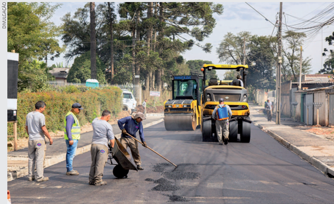
Após execução das obras de preparação, a pista e o calçamento receberam o CBUQ a partir da rua Heitor Pallu
