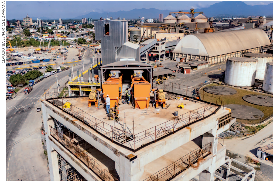
MAIOR OBRA PORTUÁRIA EM EXECUÇÃO NO BRASIL, MOEGÃO TEM INVESTIMENTO DE R$ 650 MILHÕES COM RECURSOS PRÓPRIOS DA PORTOS DO PARANÁ E FINANCIAMENTO CONCEDIDO PELO BNDES
