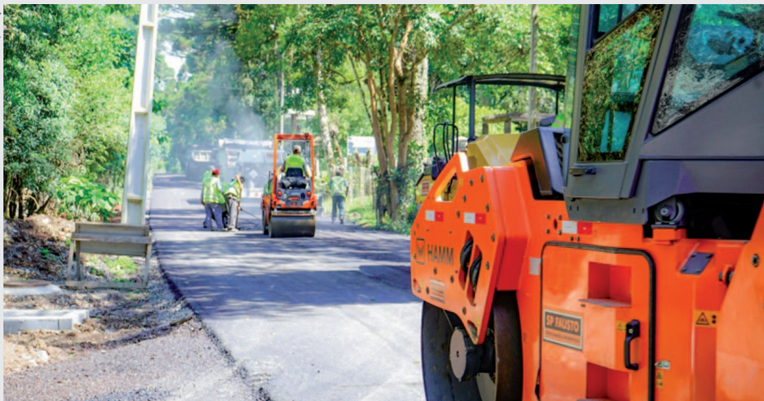
O projeto prevê as etapas de drenagem, pavimentação asfáltica e sinalização horizontal e vertical
