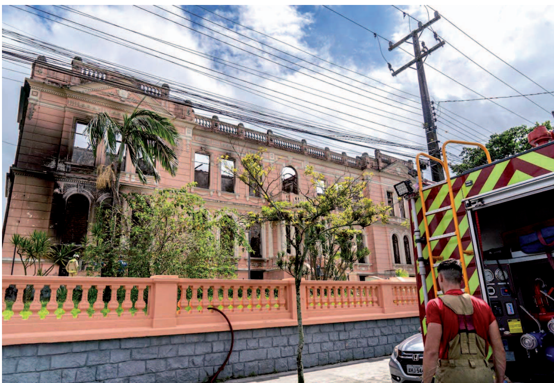
O colégio quase centenário e tombado pelo Patrimônio Histórico pelo foi atingido por um incêndio no último sábado (4)
