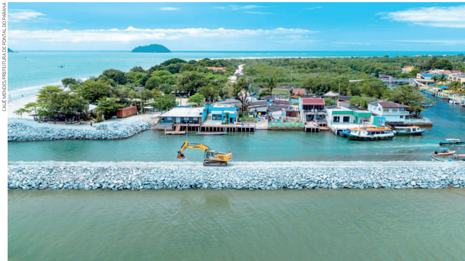
No processo, foram aplicados 40.399,49 metros cúbicos de pedras, o equivalente a 60.599,235 toneladas transportadas por 2.395 caminhões
