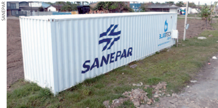
Cada reservatório contêiner possui capacidade para armazenar 70 mil litros de água tratada e é equipado com conjuntos moto-bomba, funcionando como verdadeiros "pulmões" do sistema
