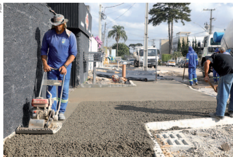
No período, mais de 25 ruas, dos diversos bairros, receberam calçada ecológica, assim chamada pela utilização de concreto poroso que, devido a sua permeabilidade, previne o acúmulo de água
