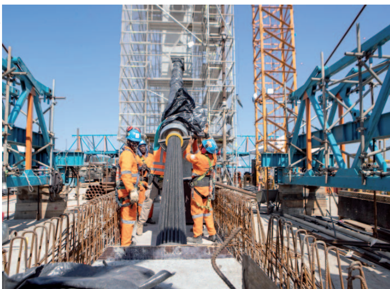
Essa é uma das últimas etapas de construção da Ponte de Guaratuba
