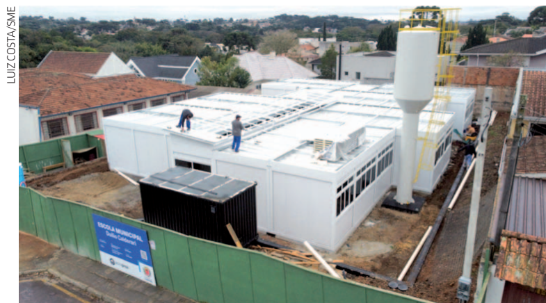
Obras de conclusão da Escola Municipal Duílio Calderari
