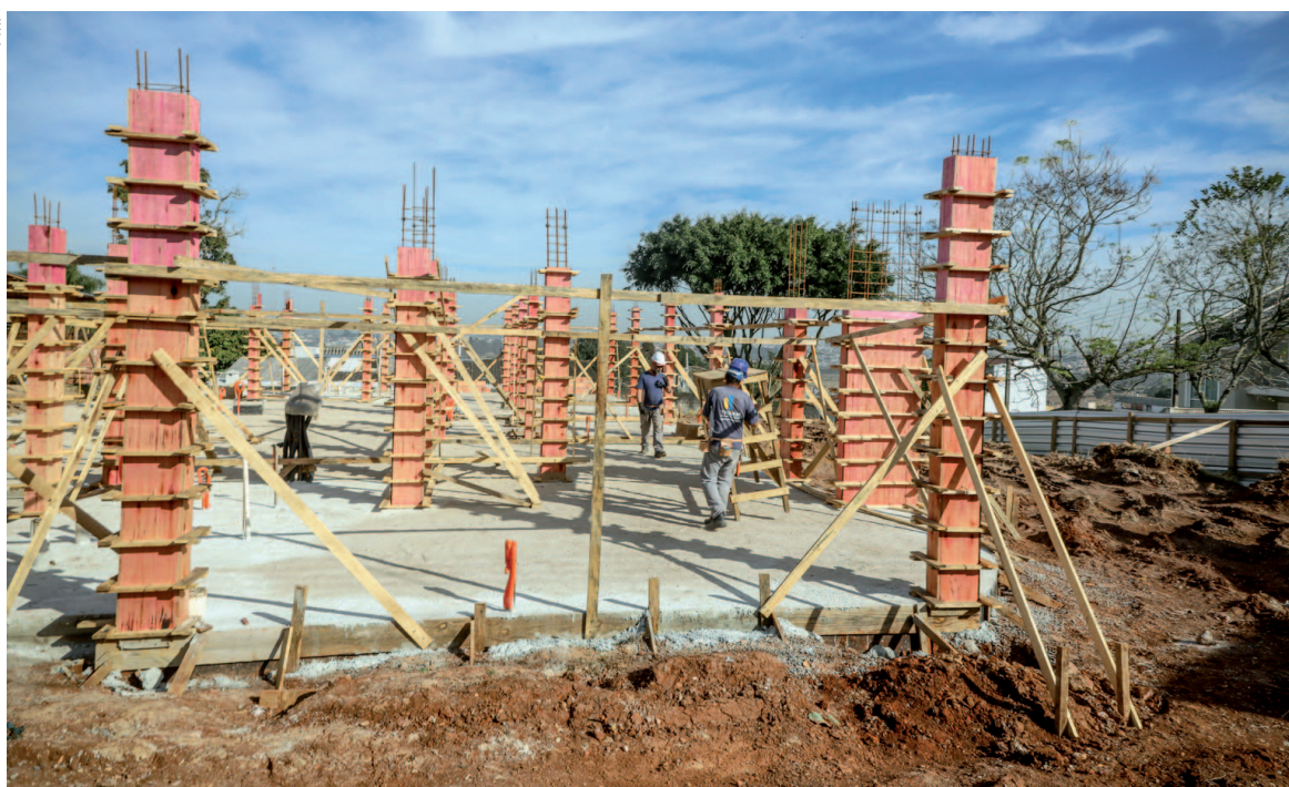
As obras do novo equipamento social da Prefeitura de Pinhais têm projeto desenvolvido pelo Parque Tecnológico Itaipu (PTI)
