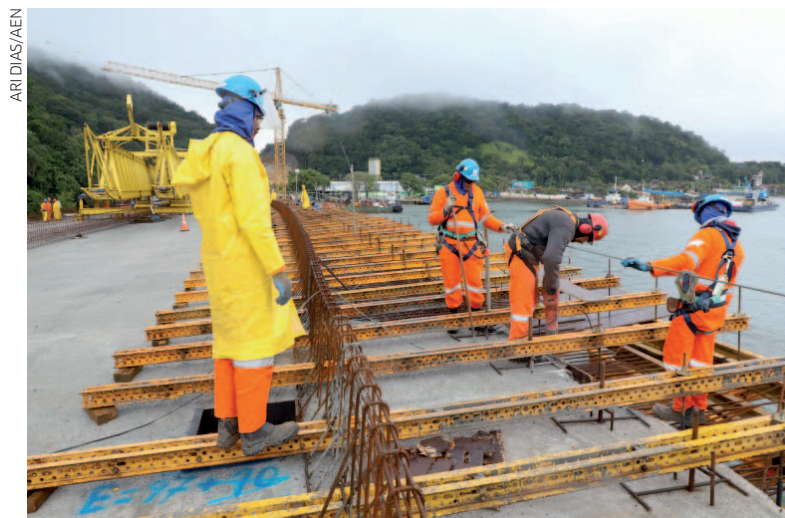
O Governo do Paraná bate recorde de investimentos no primeiro semestre de 2025 - Na foto, obras da Ponte de Guaratuba
