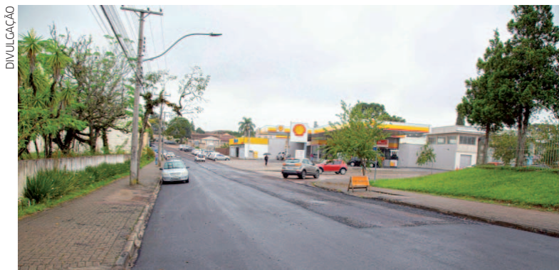
O objetivo da obra é melhorar a trafegabilidade da via e contribuir para a mobilidade urbana na região.
