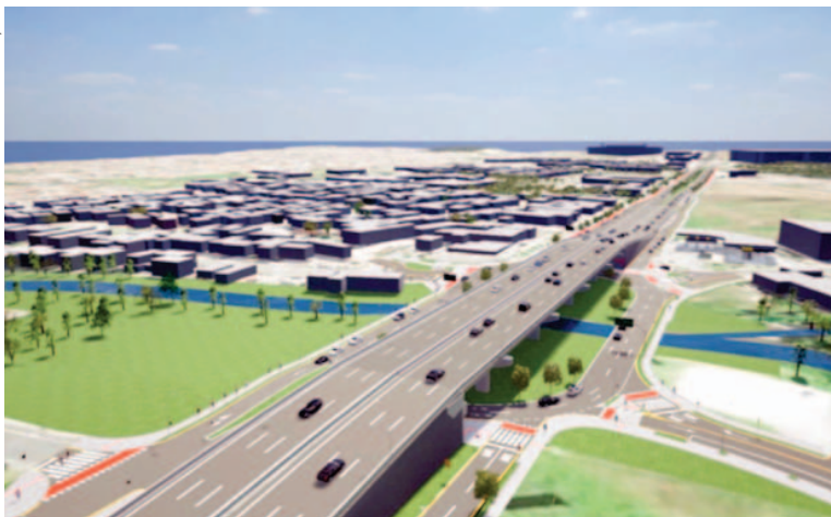
As obras fazem parte do Novo Inter 2, um dos projetos mais importantes de mobilidade em Curitiba
