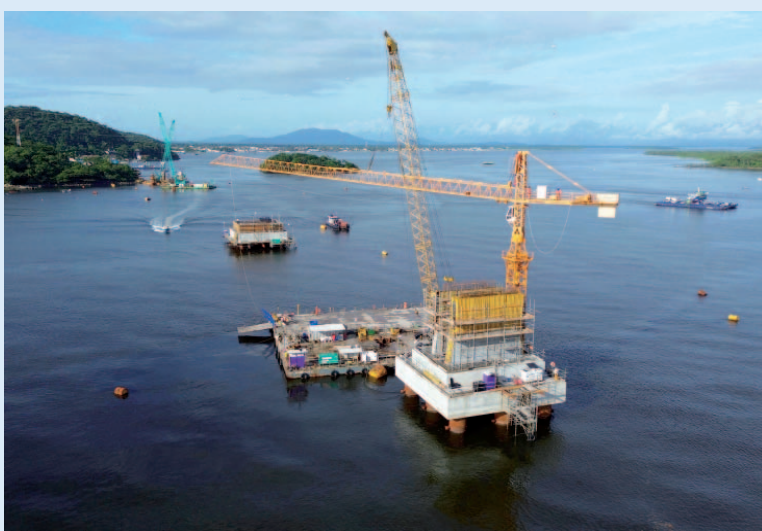
A construção da Ponte de Guaratuba pode ser acompanhada em tempo real através das câmeras de monitoramento
