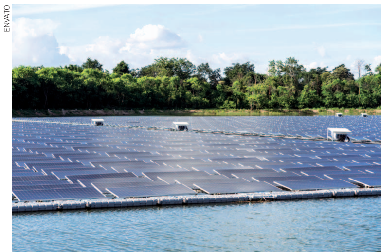
Imagem ilustrativa de usina solar flutuante
