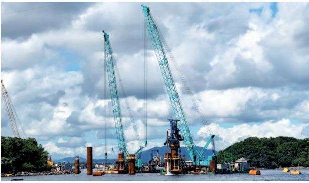
A construção da Ponte de Guaratuba pode ser acompanhada em tempo real através das câmeras de monitoramento
