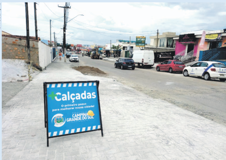
O trecho entre a Rua José Sbalchiero e a Rua Angelo Antônio Zanchetin, será alvo de diversas intervenções até a conclusão das obras
