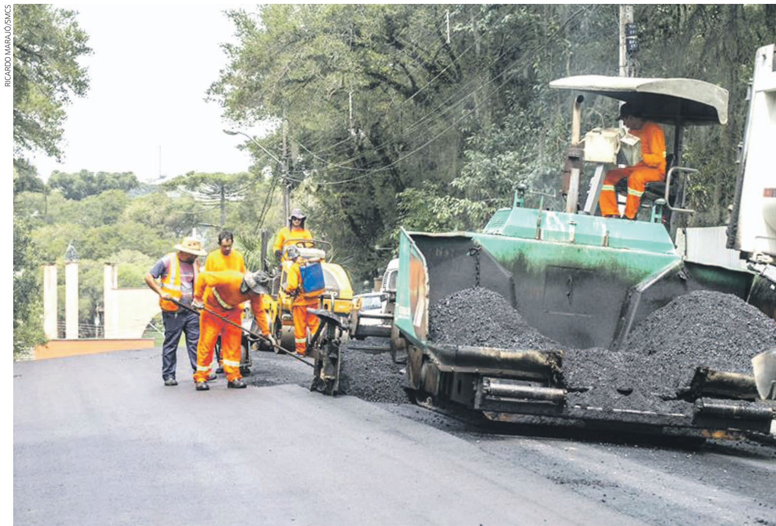
Obras de reciclagem de asfalto na rua Calisto Cumin em Santa Felicidade
