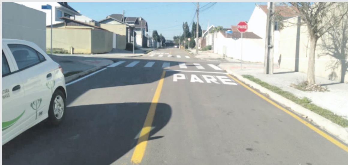
As obras na Rua Terra Boa, localizada no bairro Emiliano Pernetá, estão próximas de serem 100% concluídas
