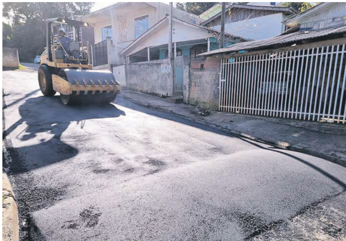
A SEMOP organizou uma operação específica para a realização dos reparos, com aplicação de camada asfáltica
