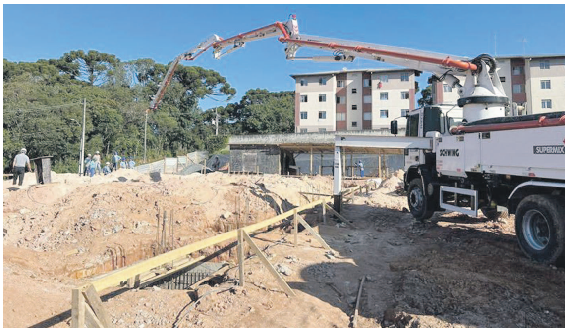
Construção da Escola Municipal Metry Bacila, no bairro Santa Cândida, que terá capacidade para atender 600 estudantes do ensino fundamental
