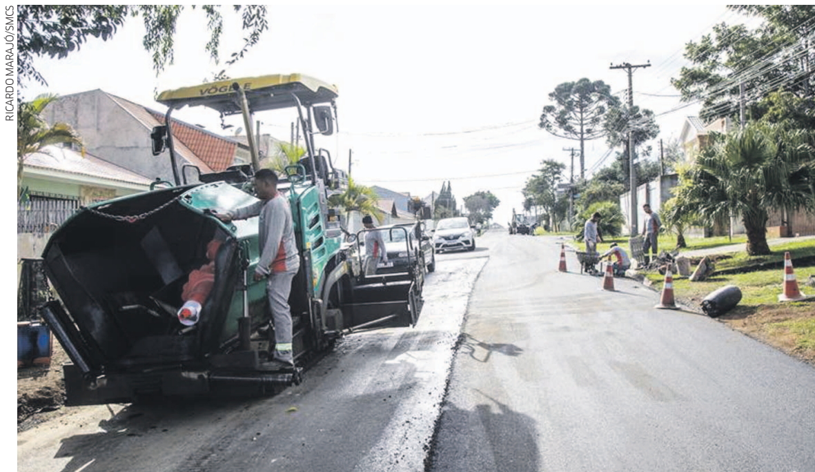
Obras de revitalização do asfalto da rua Jorge Wendler na Regional Boqueirão
