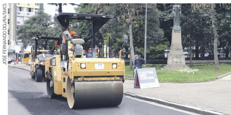
Obras de fresa e recape asfáltico em trecho da Praça Tiradentes
