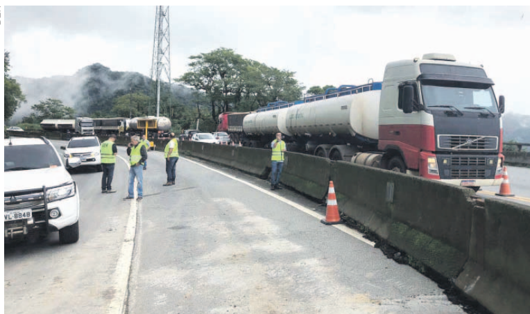
A liberação da faixa vai desafogar o trânsito de veículos no local, que permanecerá em duas faixas somente entre os km 41 e km 42
