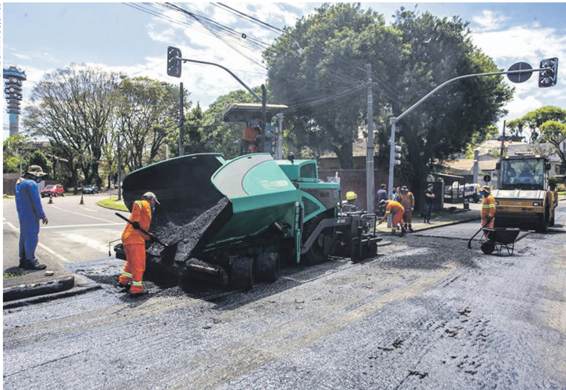
Prefeito Rafael Greca, vistoria obras de fresa e recape na rua Rua Cândido Hartmann, no Bigorrrilho
