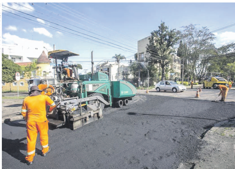
Obras de requalificação do asfalto na Rua Augusto Stresser no bairro Alto da XV
