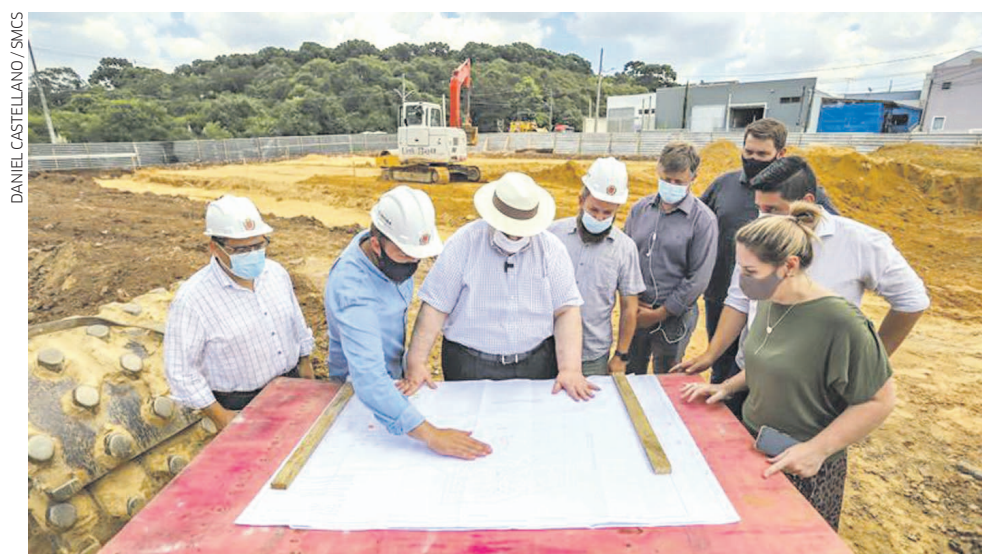
Prefeito Rafael Greca vistoria obras de construção do CMEI Dom Barusso no bairro Ganchinho
