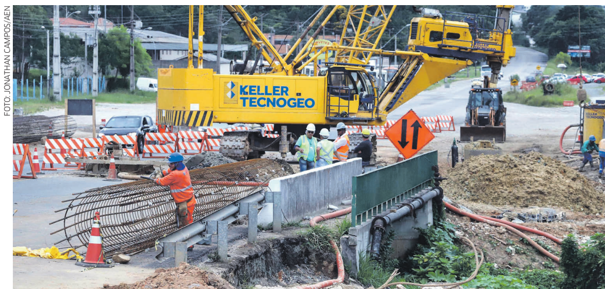
Mais de R$ 500 milhões já foram investidos em obras rodoviárias em 2021
