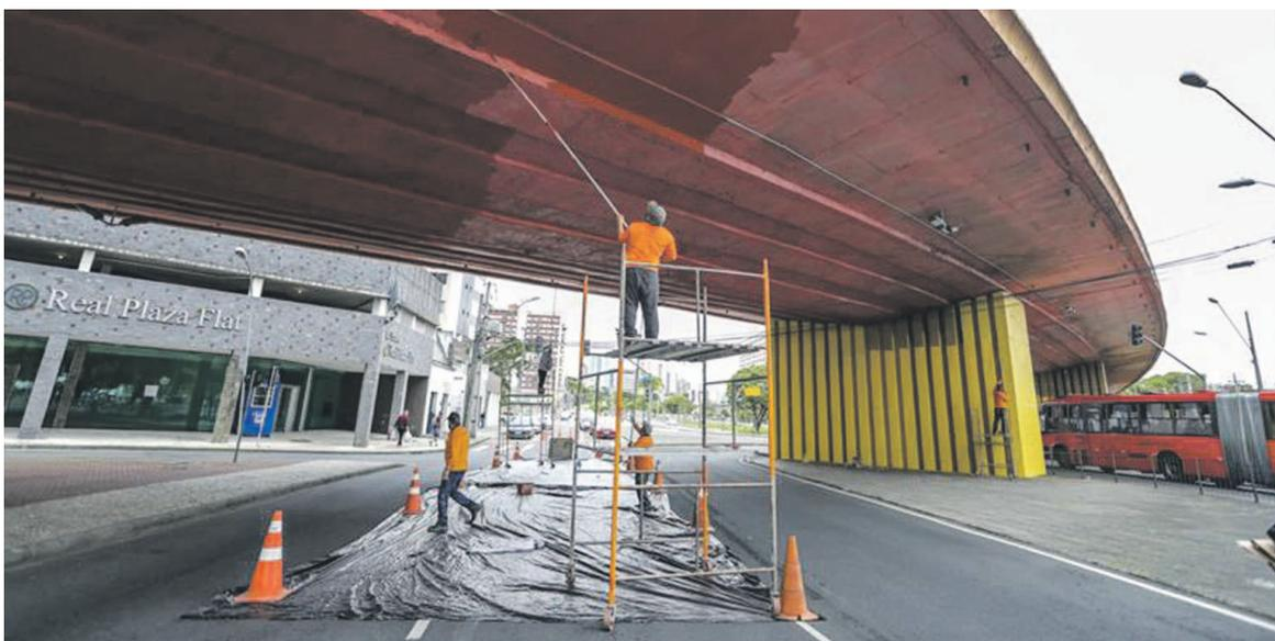
Obras de restauração, pintura e aplicação de resina antipichação no Viaduto do Capanema
