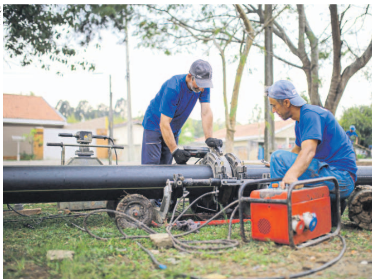
Além de melhorar o Sistema de Abastecimento de Água, as obras preveem o aumento da capacidade das tubulações de transporte de esgoto sanitário
