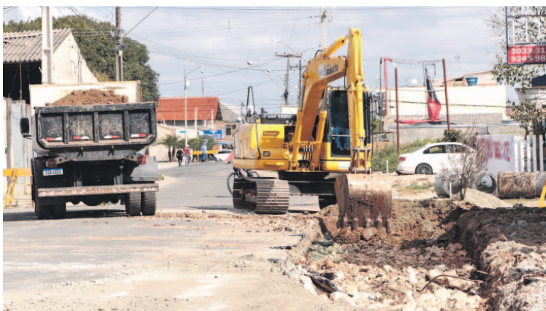
As Ruas Clemente Itsyo Horikoshi e Aroldo Camargo de Araújo receberão revisão na drenagem, nova pavimentação e outras adequações
