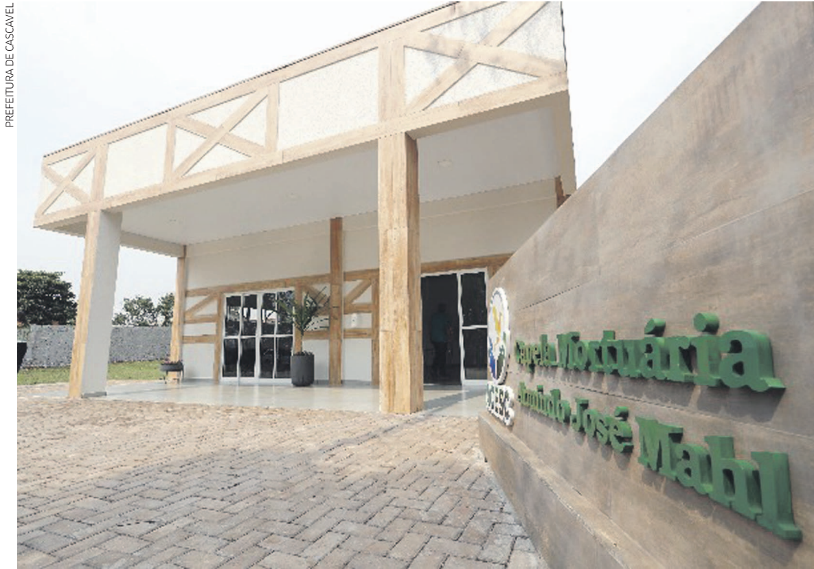
Com 160 metros quadrados de área construída, capela está equipada com ar condicionado e terá estrutura digna para aqueles que estão se despedindo de um ente querido
