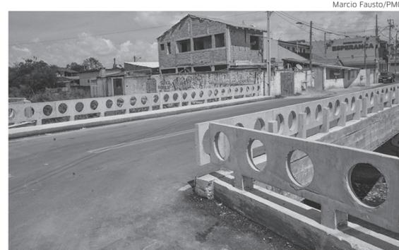
Ponte de concreto foi construída substituindo a antiga estrutura de madeira e agora conta com camada asfáltica, meio fio, mureta de proteção e sinalização
