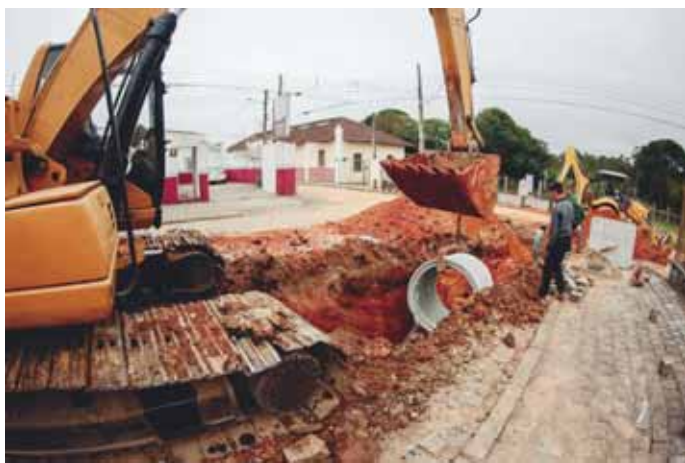
A obra está sendo executada no final da rua Barão do Cerro Azul e exige atenção e paciência dos motoristas que trafegam pelo local
