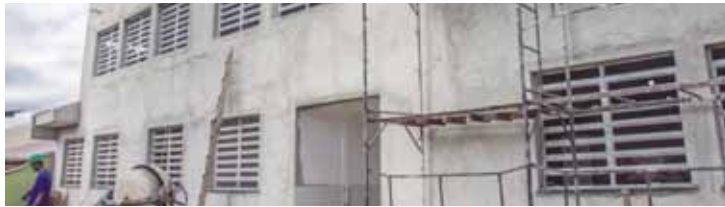
A estrutura com apenas duas salas está sendo substituída por uma nova com cinco ambientes
