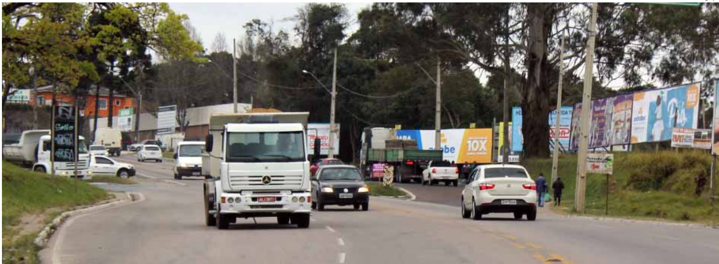
Já está em andamento a duplicação de 6,2 km da Rodovia da Uva, entre o Contorno Norte de Curitiba e a Rua Orlando Ceccon, no centro de Colombo
