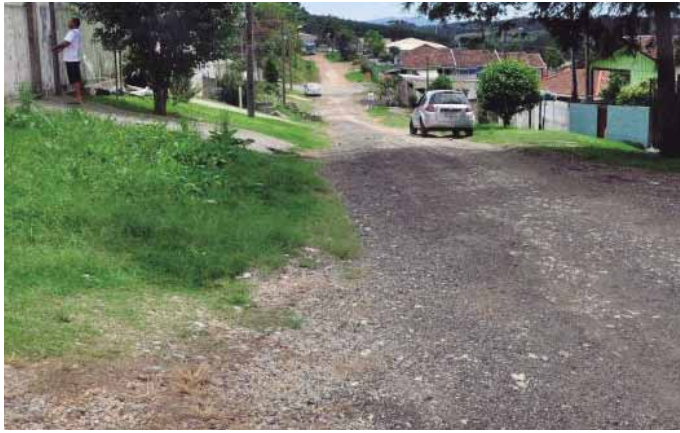
Bairro será atendido na primeira etapa da campanha de melhoria na infraestrutura urbana
