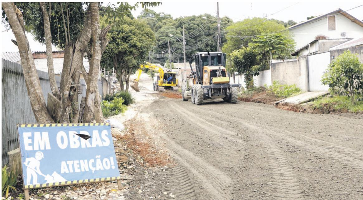
A via, que tem extensão aproximada de 200 metros, recebe reforço na base para a aplicação do Concreto Betuminoso Usinado à Quente
