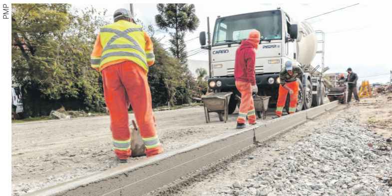
Nos próximos dias está programado o início da pavimentação em asfalto definitivo
