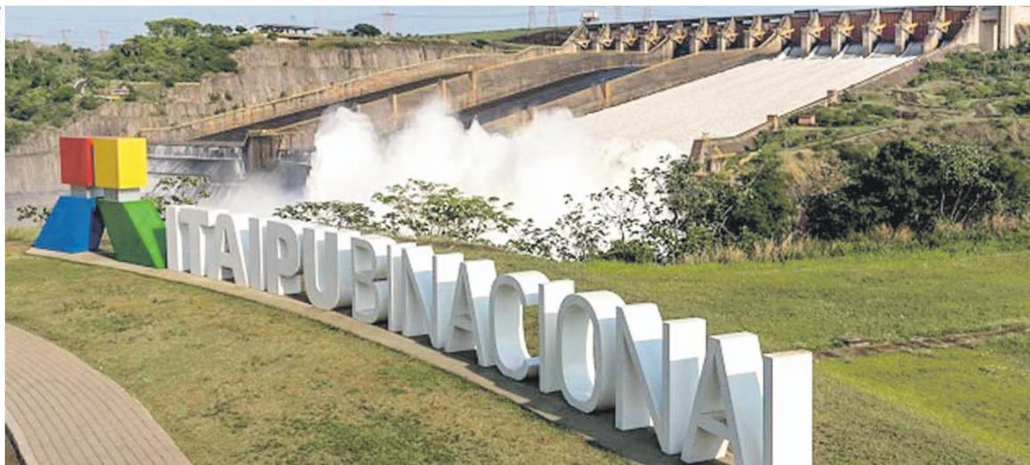
Com 20 unidades geradoras e 14 mil MW de potência instalada, a Itaipu Binacional é líder mundial na geração de energia limpa e renovável
