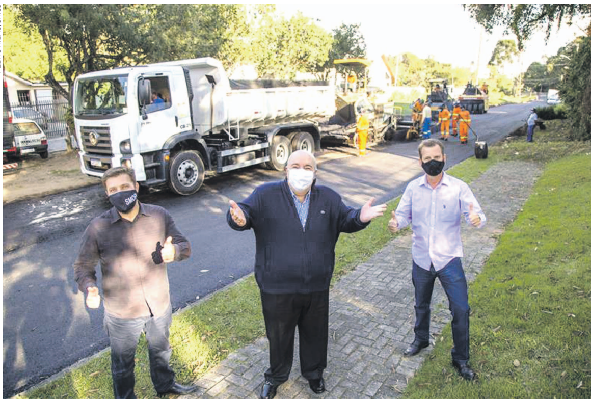
Prefeito Rafael Greca vistoria com o secretário de Obras, Rodrigo Rodrigues e com o vereador Mauro Ignácio, as obras de pavimentação da Rua Arthur Leinig, no Vista Alegre
