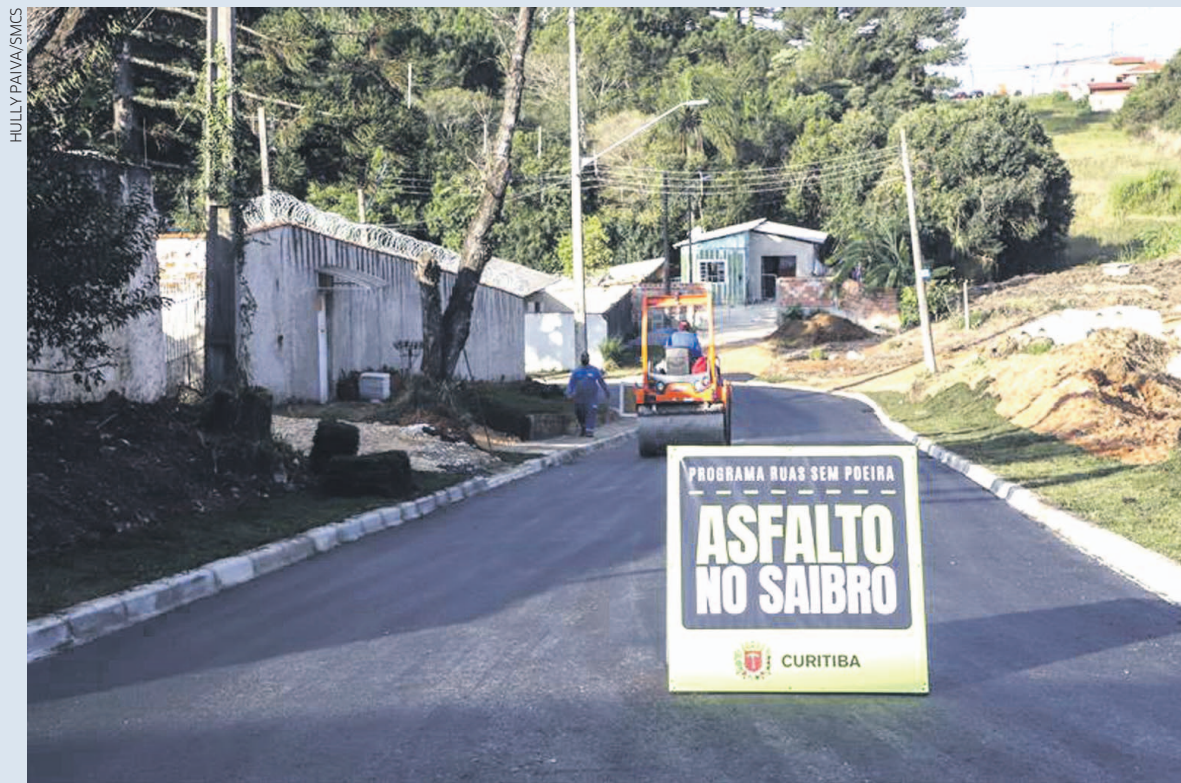
As obras do programa Asfalto no Saibro já estão em andamento em ruas da Regional Boa Vista
