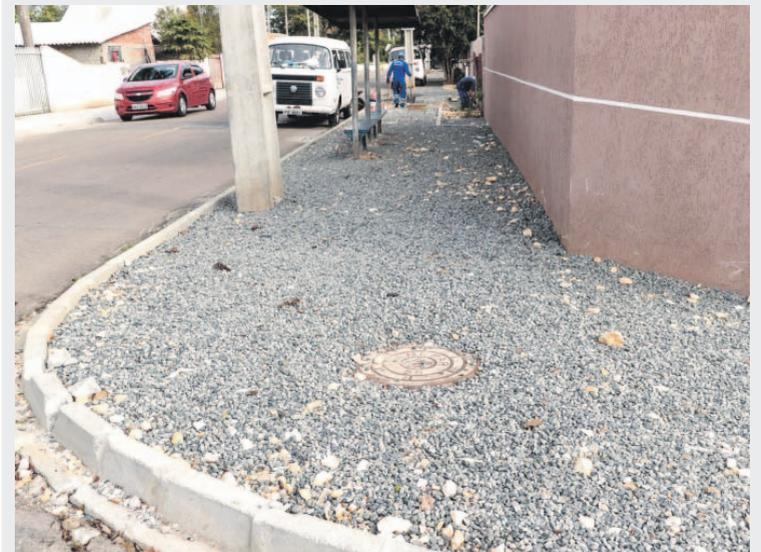
Via recebeu revisão na drenagem, instalação de meio-fio e futuramente terá iluminação LED
